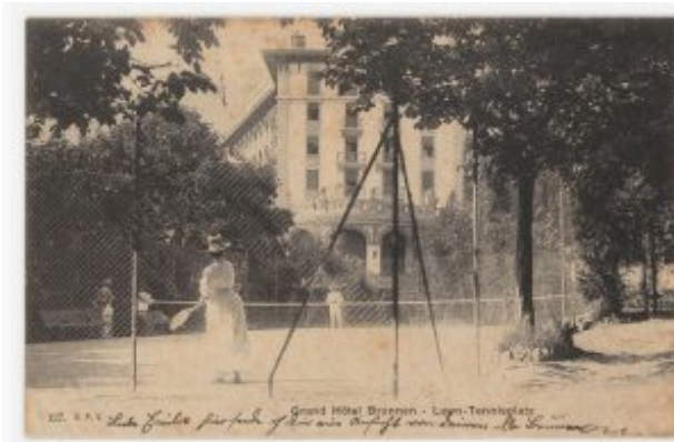
Le Grand Hôtel de Brunnen (ici, vue depuis le court de tennis) en 1908
